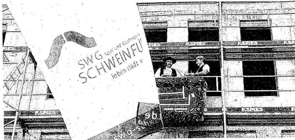
Hoch oben: Den Richtspruch sagte Zimmermann Jerry Butzke.
