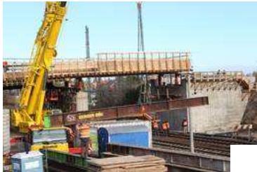
Schwere Last: Ein Stahlträger hängt nahe dem Bahnhof Finkenheerd an den Ketten eines Autokrans. Das Gerüstteil hat bis diese Woche den Betonkörper der neuen Brücke, welche Teil der Bahnhofstraße ist, getragen.
